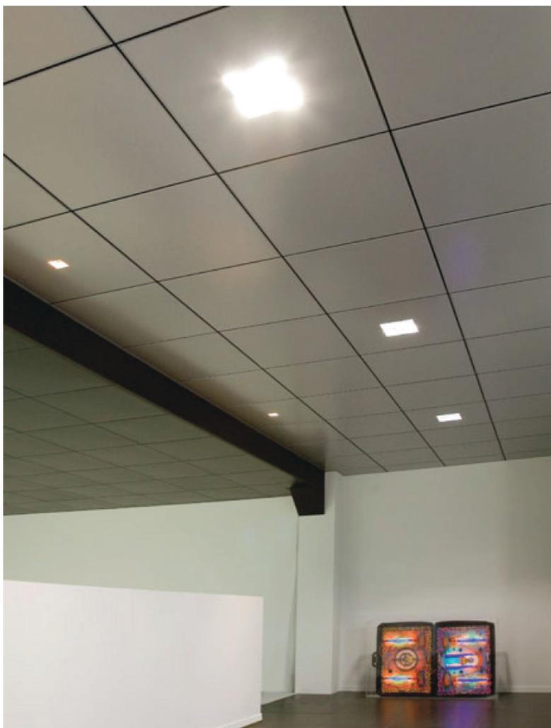
■ La forme unique du profil Colorline crée un joint creux de 8 mm à l'intérieur du profil. Ce joint peut être encore accentué en recourant aux combinaisons de couleurs suivantes:
